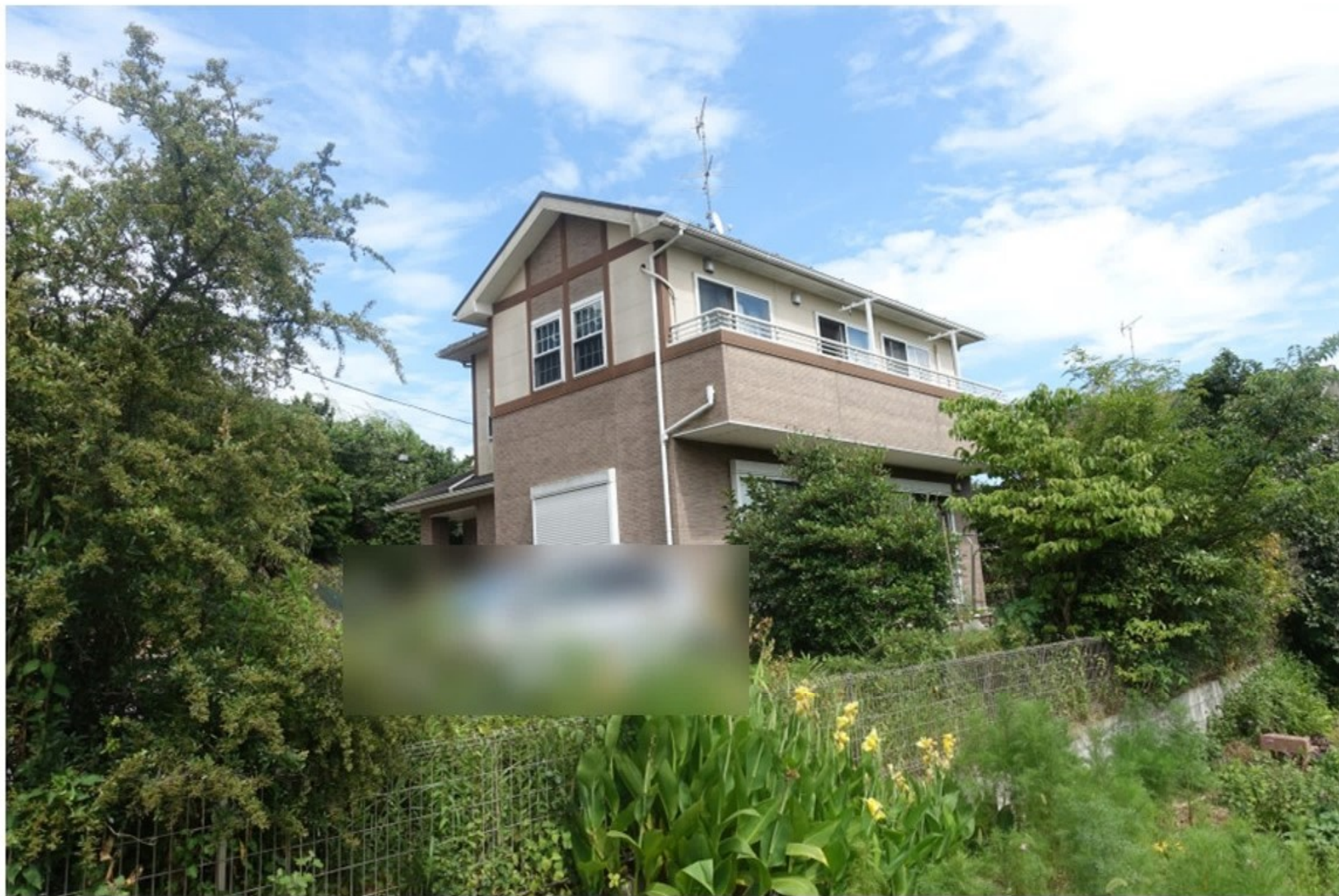
北西方向から撮影
