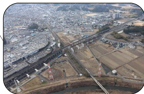
国道464号（北千葉道路）
