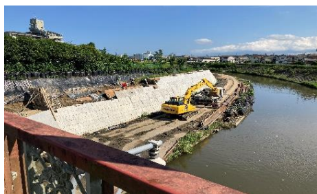
河道拡幅・護岸整備
