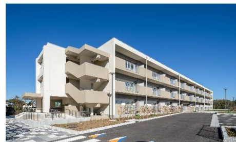
県営住宅の建設・建替・改善工事
