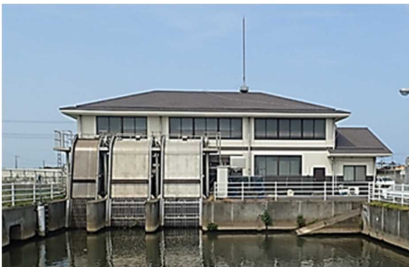
ポンプ場の整備
