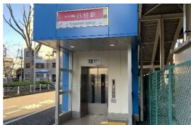
鉄道駅エレベーター
