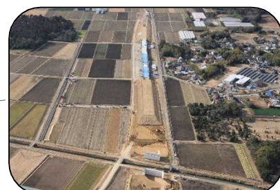
国道126号（銚子連絡道路）
