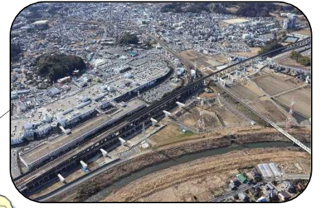
国道464号（北千葉道路）
