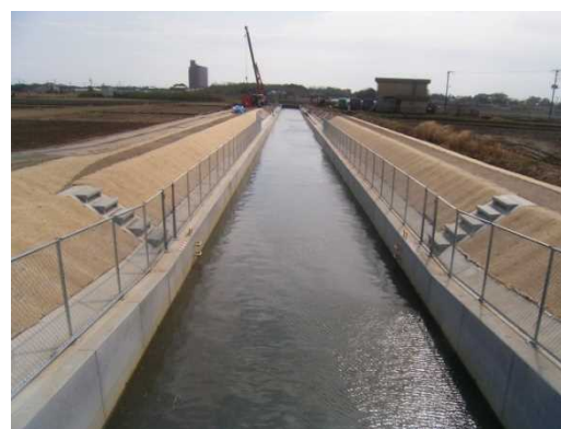
排水路の拡幅・かさ上げ
