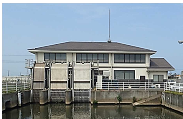
ポンプ場の整備
