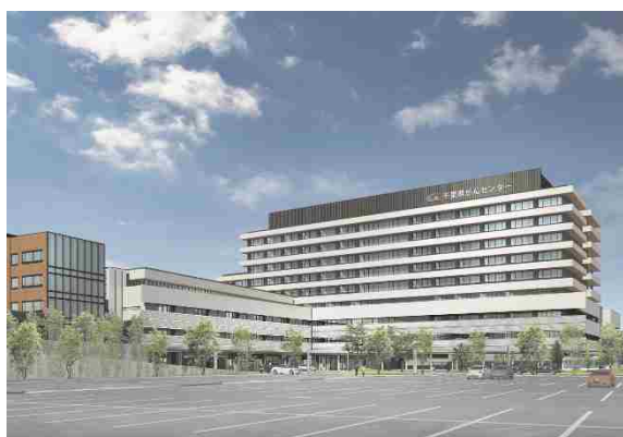
外観(既存病棟等解体後)
