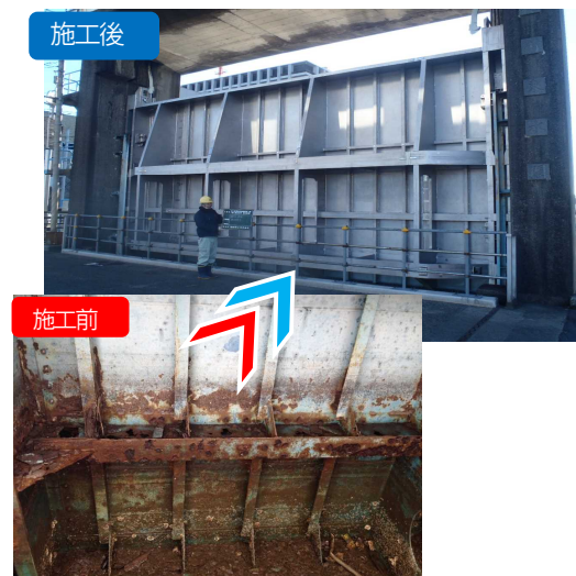
河川管理施設長寿命化
