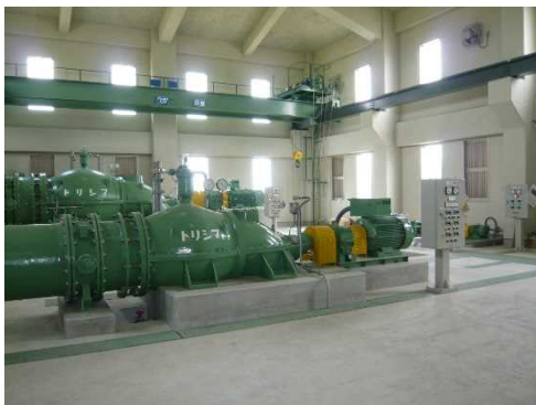
ポンプの整備
