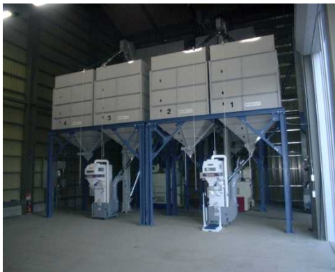
調製設備（粳タヅ・粳すり機・選別機）
