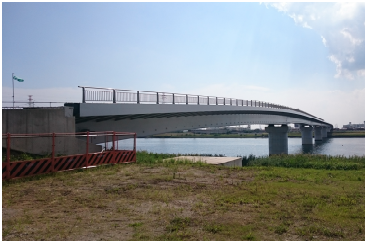
船橋行徳線 ((仮称) 妙典橋)
