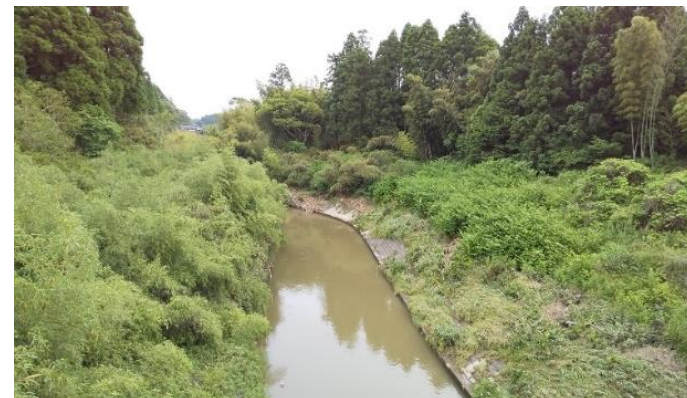
【河川】 河道内の堆積土砂撤去及び竹木伐採
