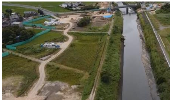
【河川】 河道拡幅・護岸整備等
