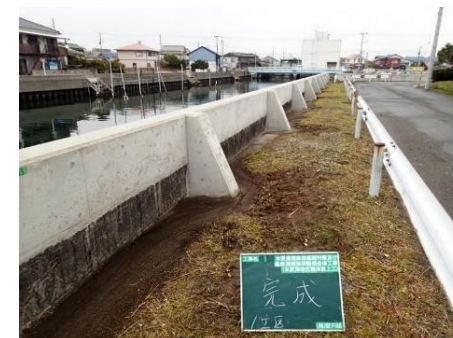
例) 護岸の嵩上げ整備
