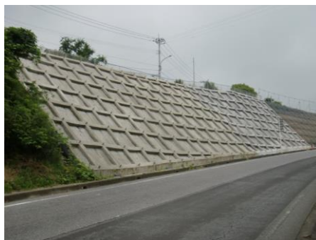
例) 道路法面工事
