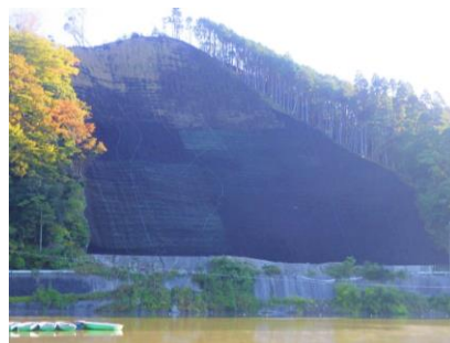
例) 山崩れや地すべり被害地の復旧
