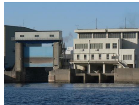
例) 水門・排水機場の改修整備
