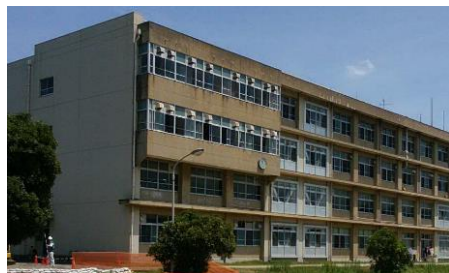
例) 船橋二和高等学校管理特別棟改修前
