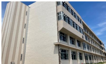
例) 船橋二和高等学校管理特別棟改修後
