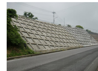
例) 道路法面工事
