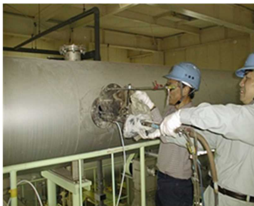
写真3 煙道の測定の様子
