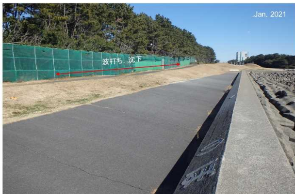
図2b 調査地の地表変形。護岸沿いの舗装道路の盛り上がり部分の脇の堤体は波打ち沈下してい
