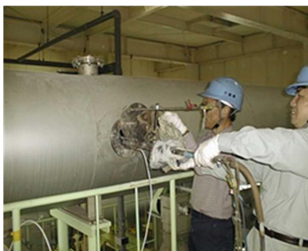
写真 3 煙道の測定の様子
