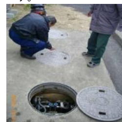
写真2 調査の様子 転落防止のためマンホールで蓋をしています。
