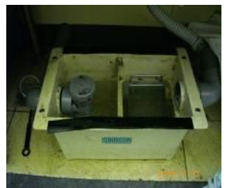
写真5 油水分離槽の状況
