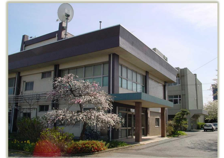
稲毛地区 地質研究棟 地質環境研究室
