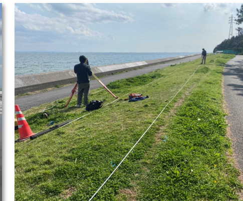
液状化による地盤の不等沈下地点での調査
