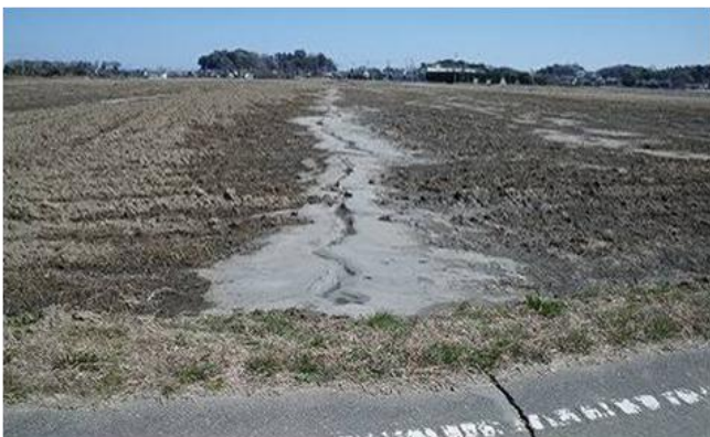
図5 2011年東北地方太平洋沖地震による香取市神崎町小松飛地(旧河道)における長い亀裂と噴砂。
