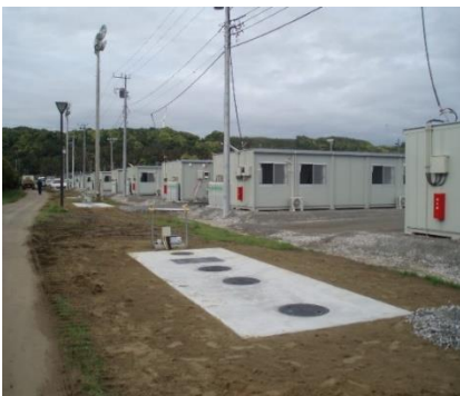
図-16-5 応急仮設住宅（建設型）設置状況 （旭市：東日本大震災による）
