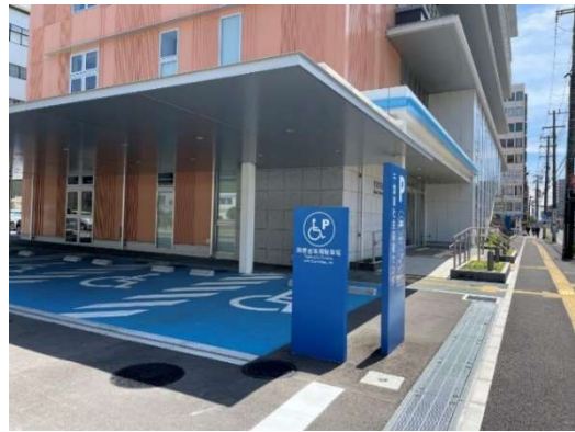
千葉県社会福祉センター（注意喚起用床材、誘導用床材及びスロープ）
