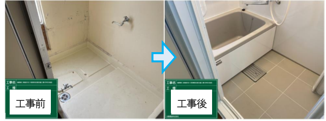
浴室（ユニットバスへ改修）
