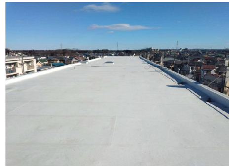
小倉県営住宅屋上断熱防水改修工事写真 令和4年度(2022)完成
