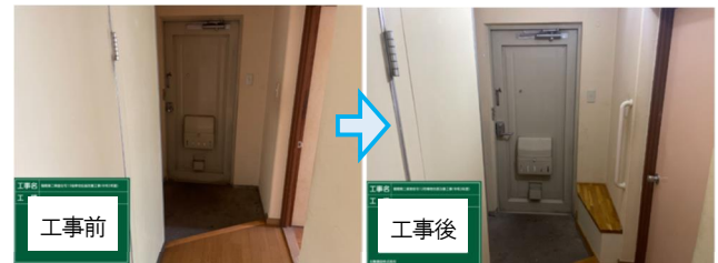
玄関（手摺・ベンチの設置）
