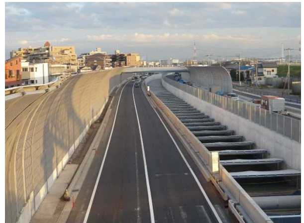
一般国道 298 号・高速道路開口部施工状況
