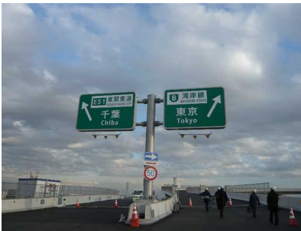
高谷料金所付近施工状況
