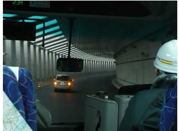
高速道路 掘割部施工状況（車窓から）
