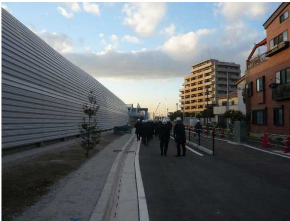
環境施設帯施工状況
