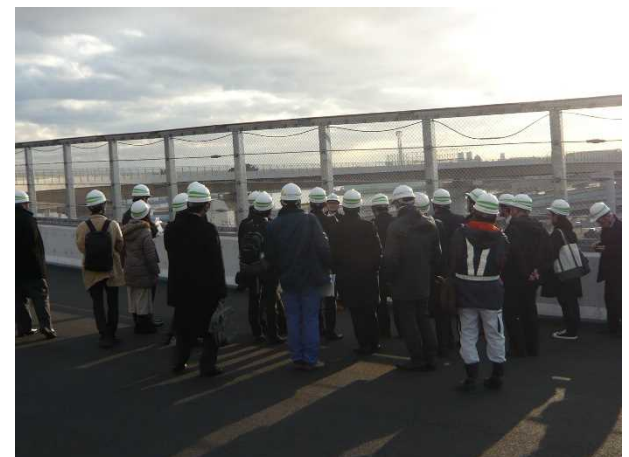
高谷料金所付近施工状況
