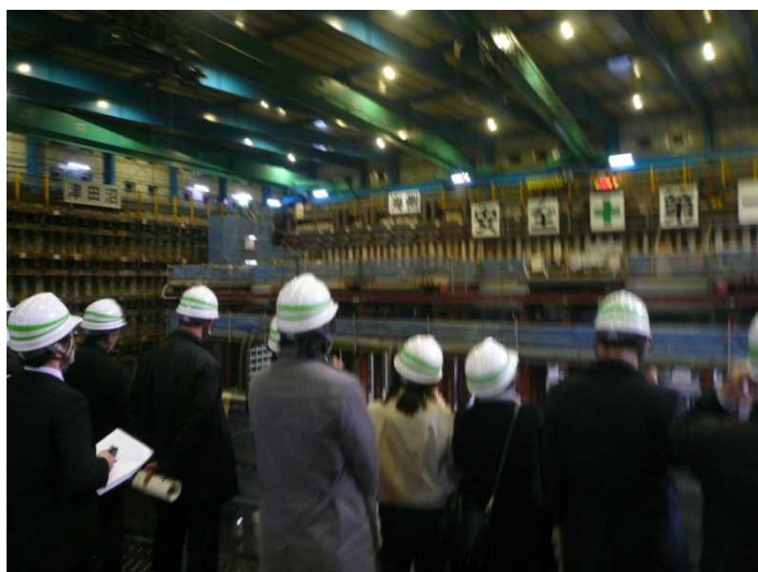
工事状況（菅野地区：京成交差部防音ハウス内）
