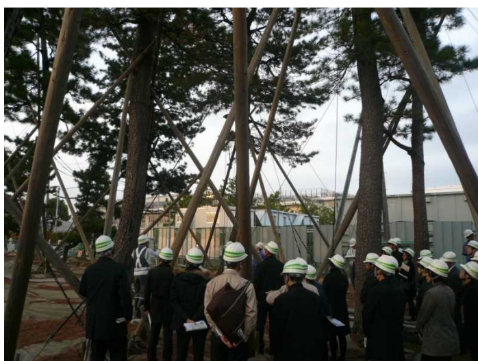
クロマツ仮移植状況（菅野地区）
