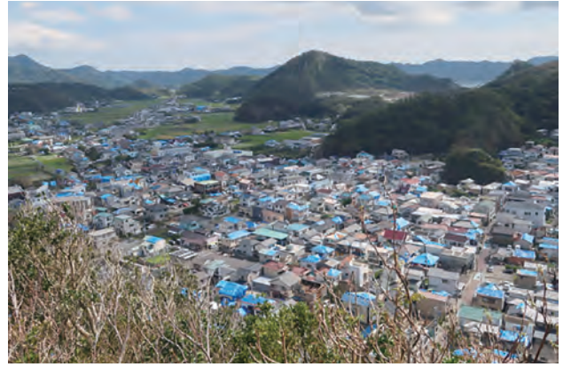
甚大な台風被害を受け、雨漏り防止のため ビニールシートで屋根を覆う。 (写真：令和元年房総半島台風)
