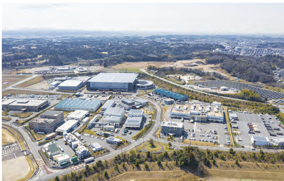
企業誘致の推進による産業振興と雇用場の確保を図ることを目的として整備が進められた 椎の森工業団地 (写真：袖ヶ浦市/ 椎の森工業団地)
