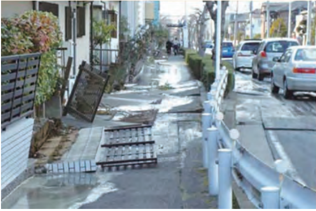
埋立地の多い本県では、液状化現象が発生しやすい。 (写真:習志野市/ 東日本大震災)
