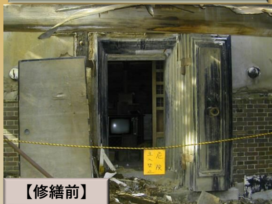
土蔵の修繕（吉岡蔵）
