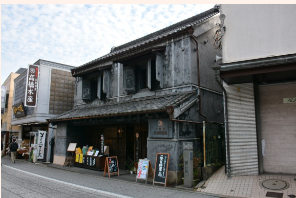
みせぐらづくり 伝統的な見世蔵造りで建てられた店舗
