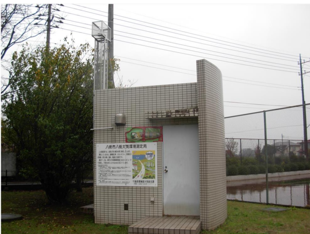
大気環境常時監視測定局(八街市八街局)
