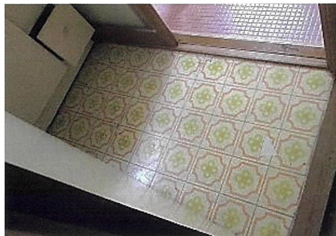
床に使用した例(Pタイル)
