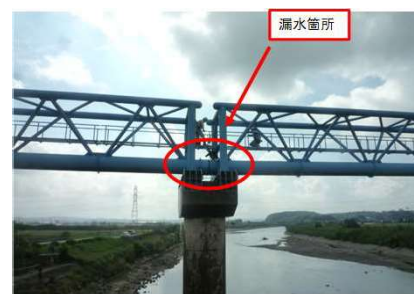
養老川水管橋
