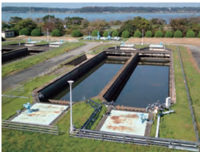
●取水場（印旛取水場）
