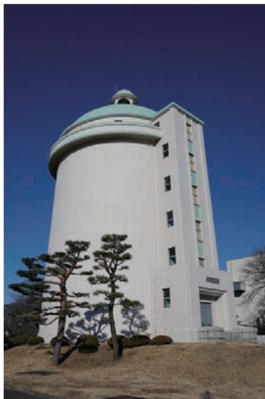
1937（昭和12）年に かんせい 完成した けんえいすいどう 県営水道の くりやまはいすいどう 栗山配水塔 (平成18年土木学会選奨土木遺産認定) ど ぼく が っ かい せん しょう ど ぼく い さん に ん てい (平成29年登録有形文化財(建造物)登録)
