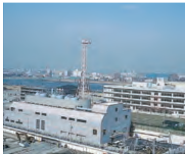
きゅうすいじょう みょうでんきゅうすいじょう ●給水場 (妙典給水場) じょうすいじょう おく た すいそう 浄水場から送られてきた水を貯める水槽があります
