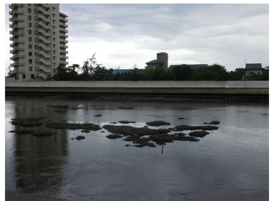
図 11 工事後のカキ礁の状況
