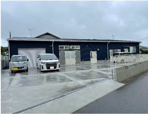
図5 完成直後の加工場（令和4年6月）
