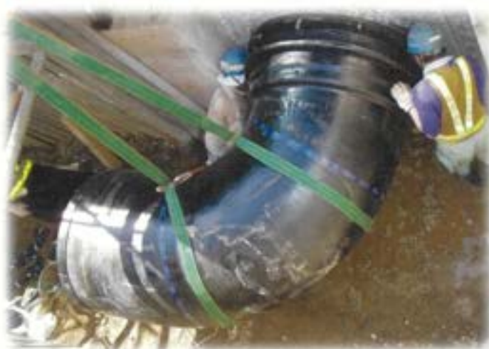
配水管布設替工事
