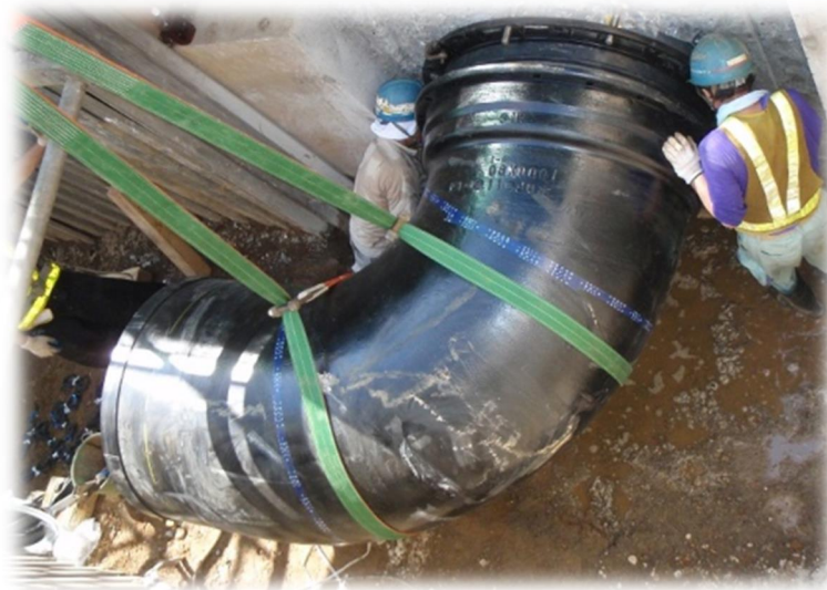
配水管布設替工事
