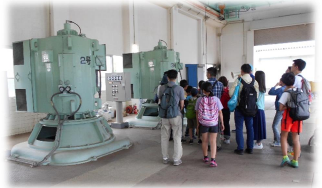
浄水場施設見学の様子（ポンプ設備）
