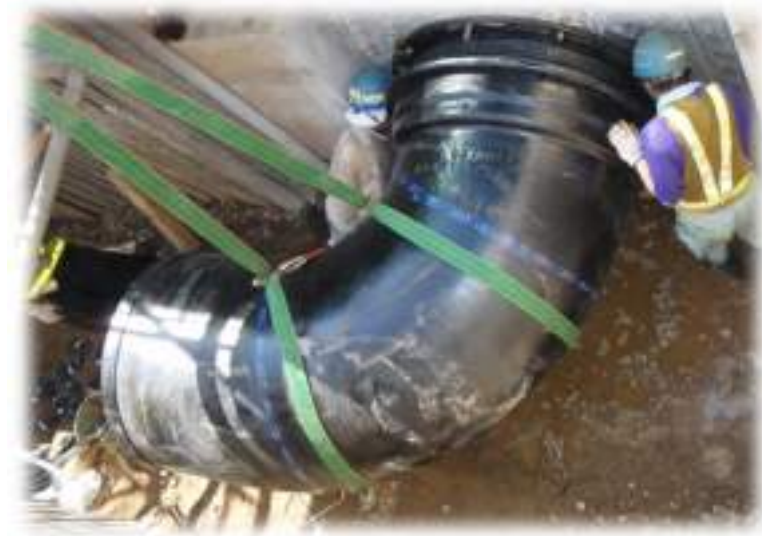
配水管布設替工事
