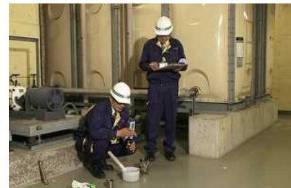
図 3 - 1 6 貯水槽施設の点検
