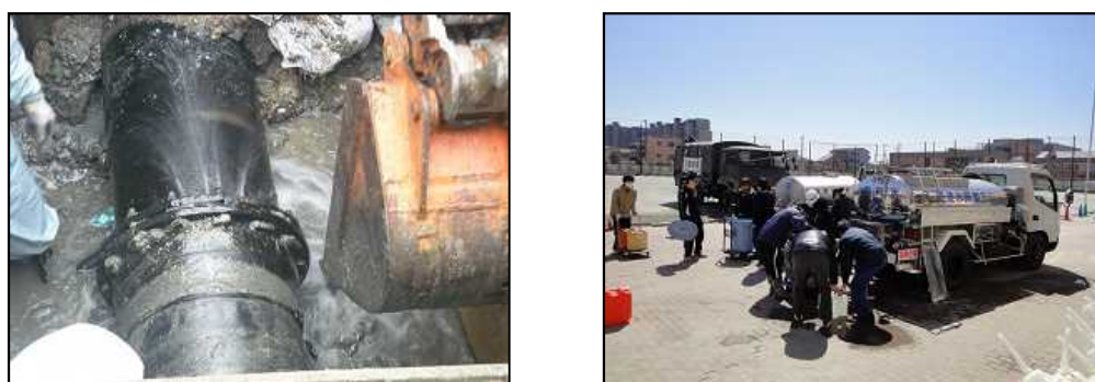
図2-10 東日本大震災における漏水被害(左)及び応急給水活動の様子(右)
