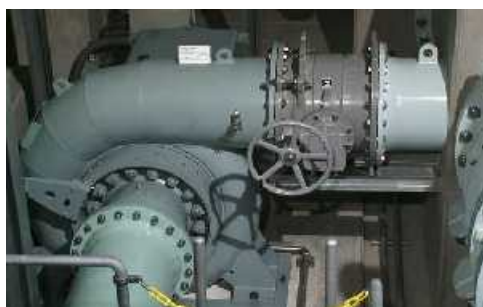
図3-21 マイクロ水力発電設備（妙典給水場）（左）及び太陽光発電設備（ちば野菊の里浄水場）（右）
