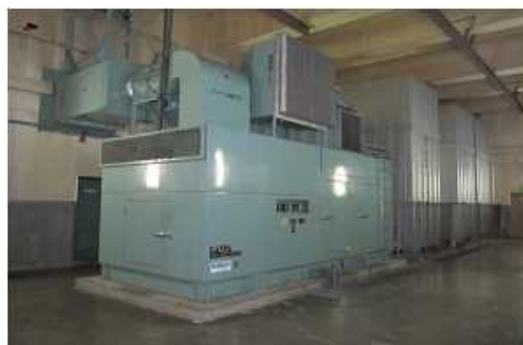
図3-3 自家用発電設備
