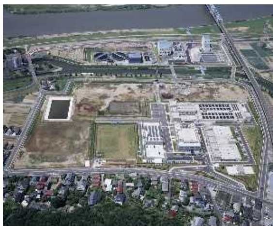
ちば野菊の里浄水場
