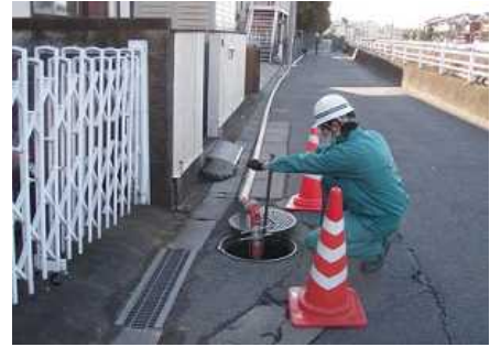
図 3 - 1 5 水道管の洗浄作業
