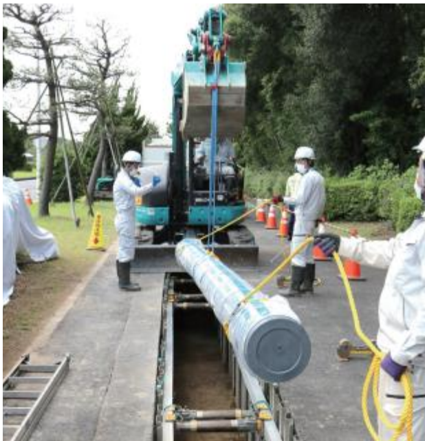
水道管の取り替え工事
