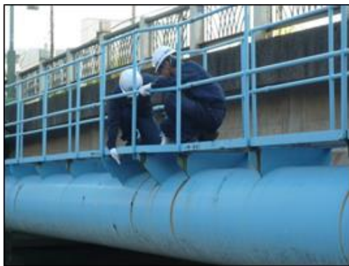
図3-2 管路パトロール
