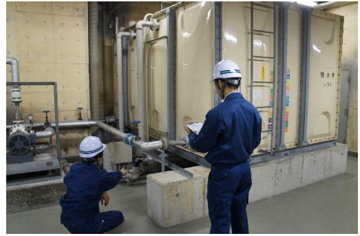
図5-12 貯水槽施設の点検
