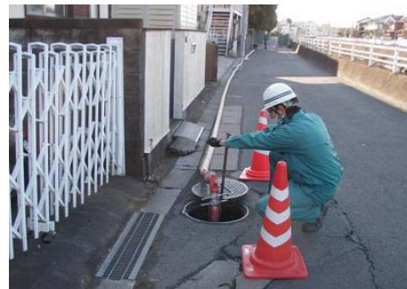
図5-11 水道管の洗浄作業
