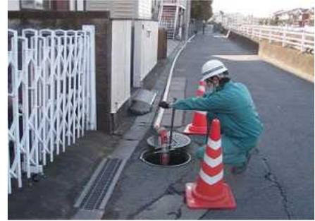
図 3 - 1 5 水道管の洗浄作業
