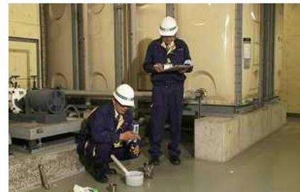
図 3 - 1 6 貯水槽施設の点検
