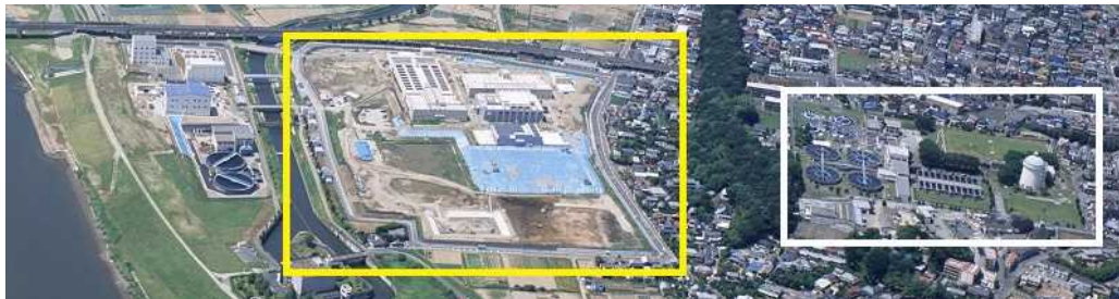
図3-1 ちば野菊の里浄水場（第2期）施設整備事業
