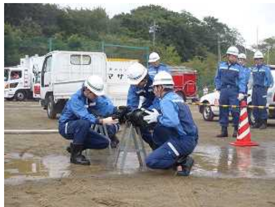
図 3-7 漏水時の応急復旧工事訓練
