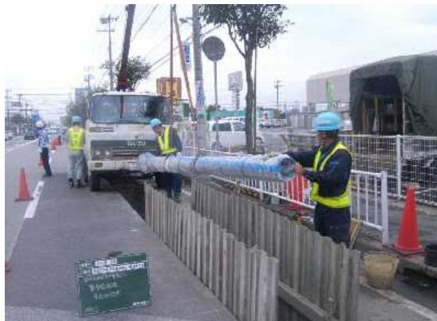
図3-4 鋳鉄管の更新工事
