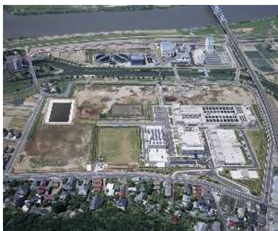
ちば野菊の里浄水場
