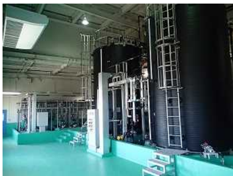
図3-2 次亜塩素酸ナトリウム注入設備
