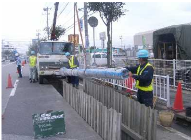
図3-4 鋳鉄管の更新工事
