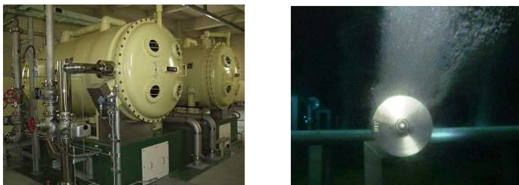
図3-11 オゾン発生器（左）とオゾン処理の様子（右）
