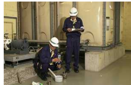
図 3 - 1 6 貯水槽施設の点検
