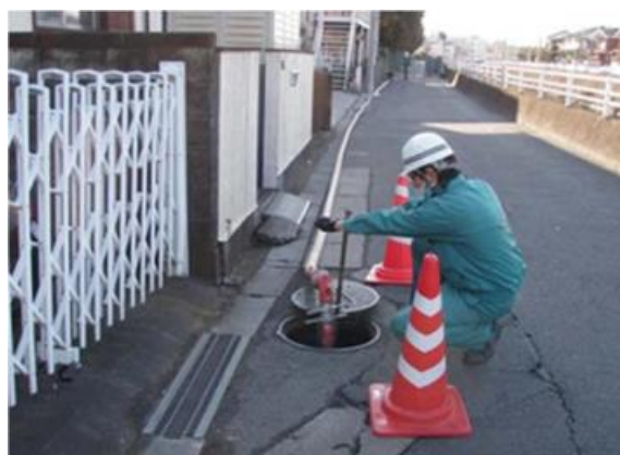
水道管の洗浄作業
