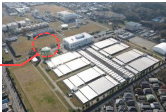
柏井浄水場西側施設洗浄水槽
