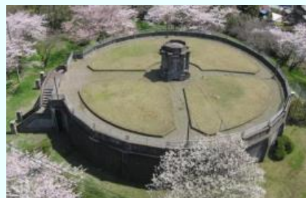
<千葉分場1号配水池>
