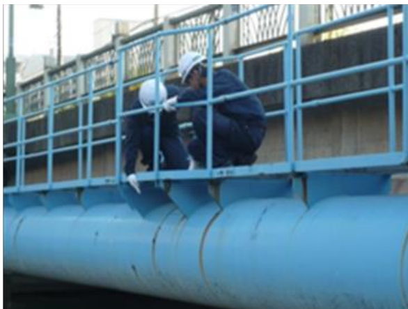
水管橋の点検
