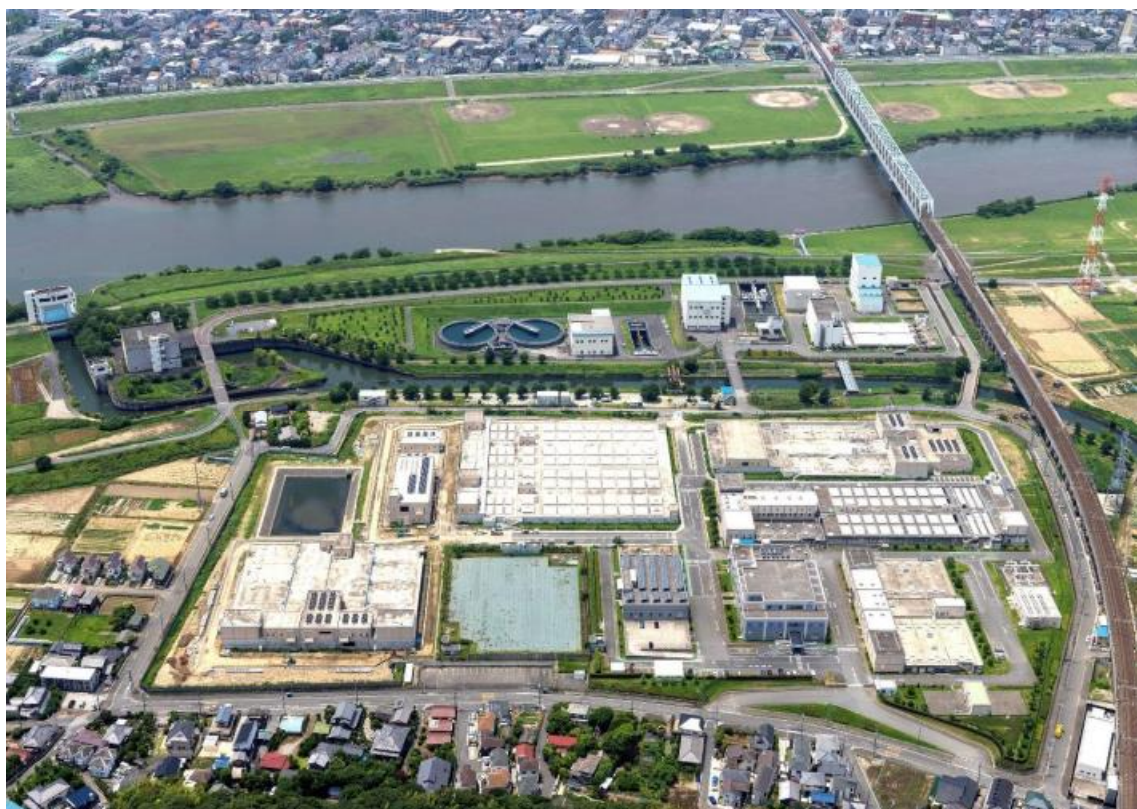
ちば野菊の里浄水場
