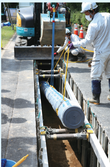
管路工事の様子
