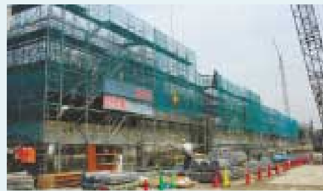
(仮称)江戸川浄水場の建設風景
