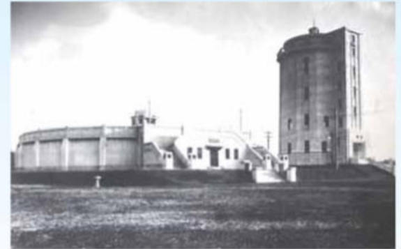
写真-① 竣工当時の配水池(左)と高架水槽(右)
