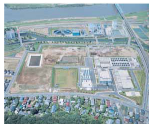
ちば野菊の里浄水場(平成19年10月稼働開始)
