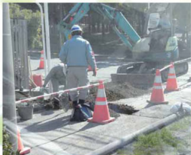
▲漏水個所の工事風景
