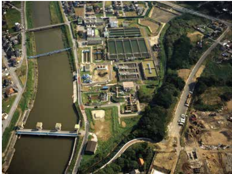
図-2.18 人見浄水場
