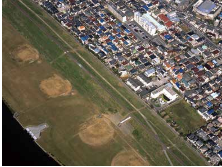
図-2.3 大和田取水場
