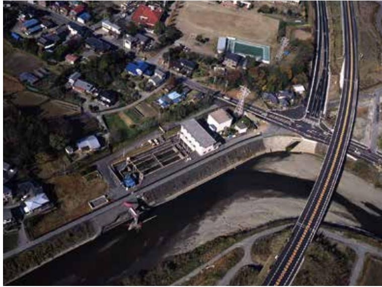
図-2.17 湊川取水場
