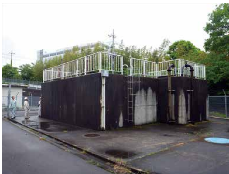
図-2.19 空港南部給水場
