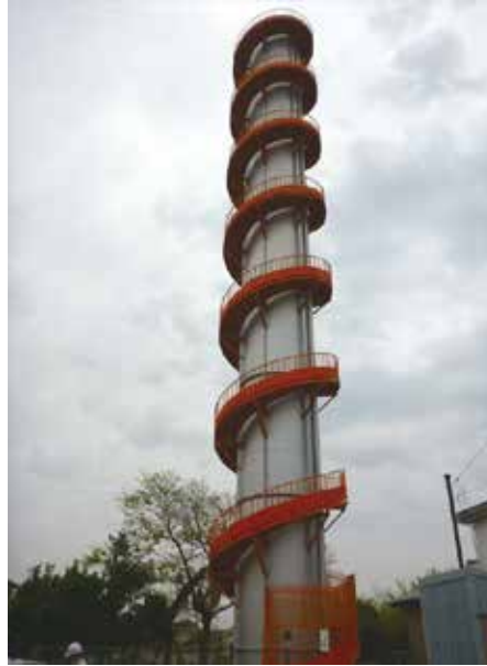
図-2.6 間野台調圧塔
