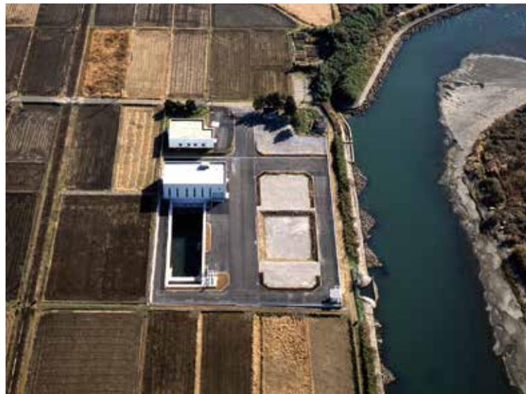
図-2.8 西広取水場
