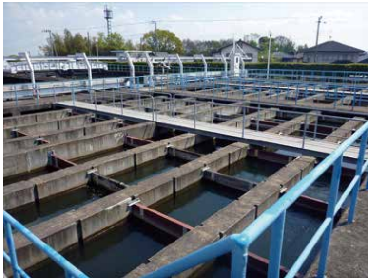
図-2.10 郡本浄水場(3・4号沈殿池)
