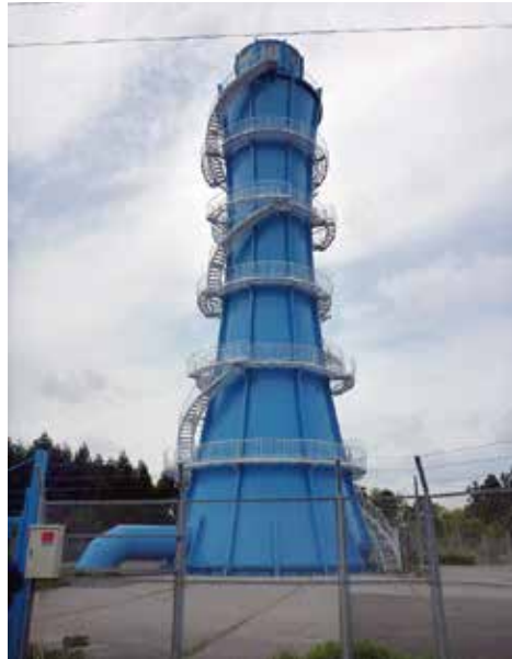
図-2.12 羽鳥調圧塔
