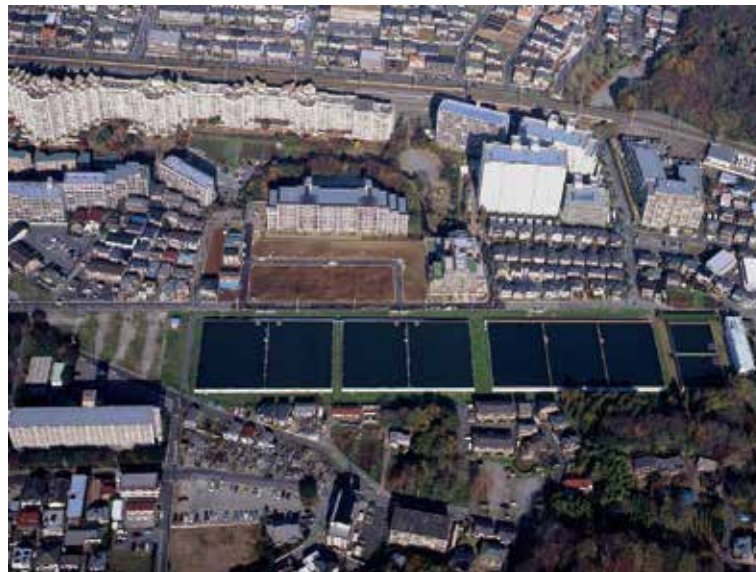
図-2.7 宮崎給水場
