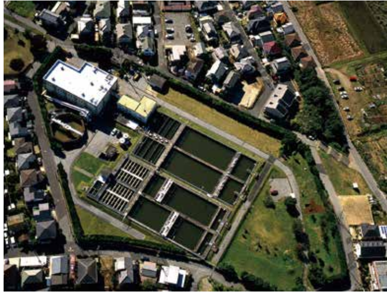
図-2.9 郡本浄水場
