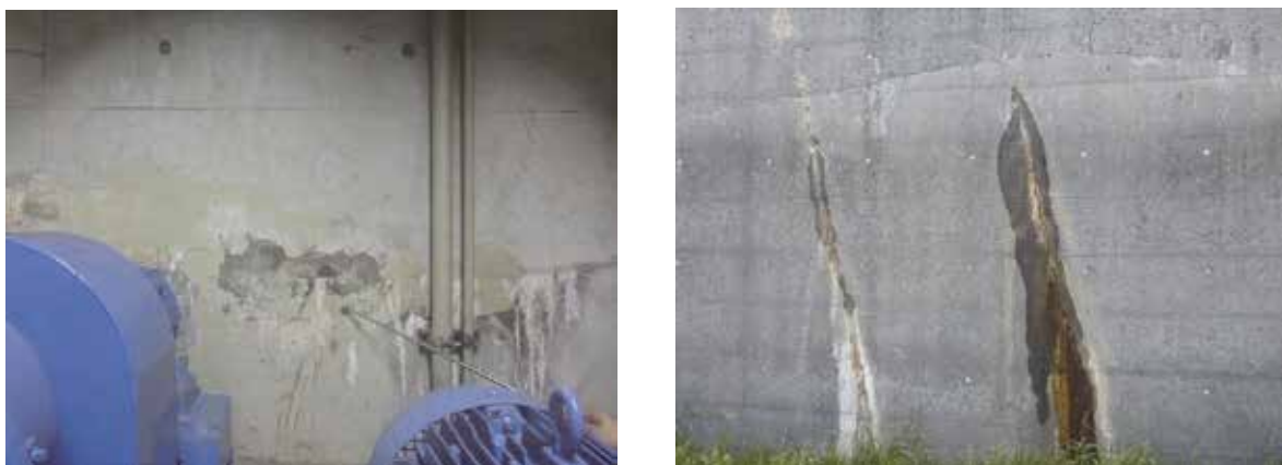
図-2.22 土木施設の劣化状況
