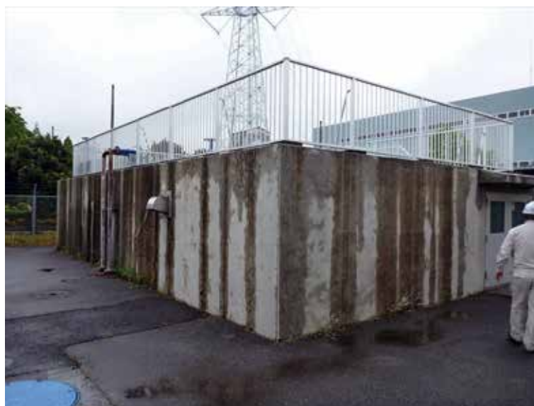
図-2.20 横芝給水場
