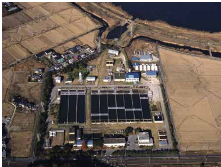
図-2.5 印旛沼浄水場
